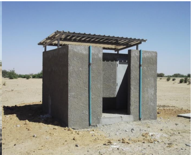
Figure 26 : Latrine du centre de santé de Dankala
