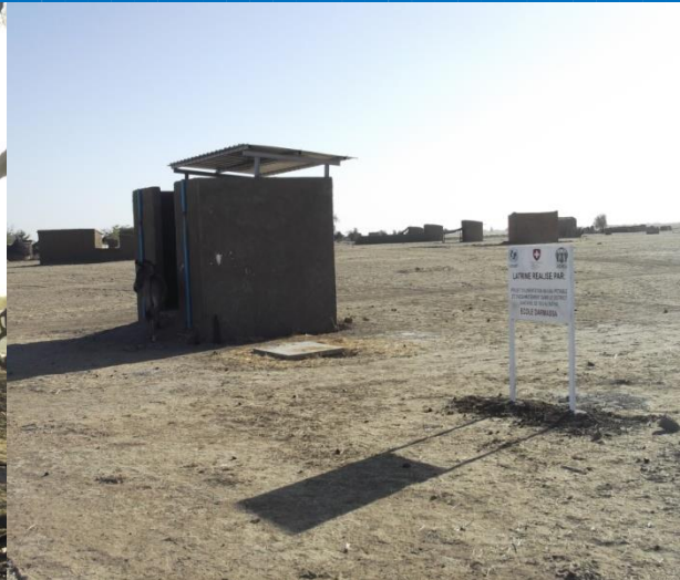
Figure 24 : Latrine de l'école de Darmassa
