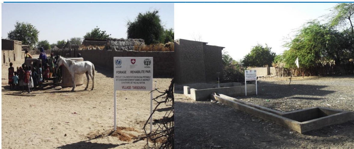
Figure 21 : Forage réhabilité de Tarsourou Warnan.
