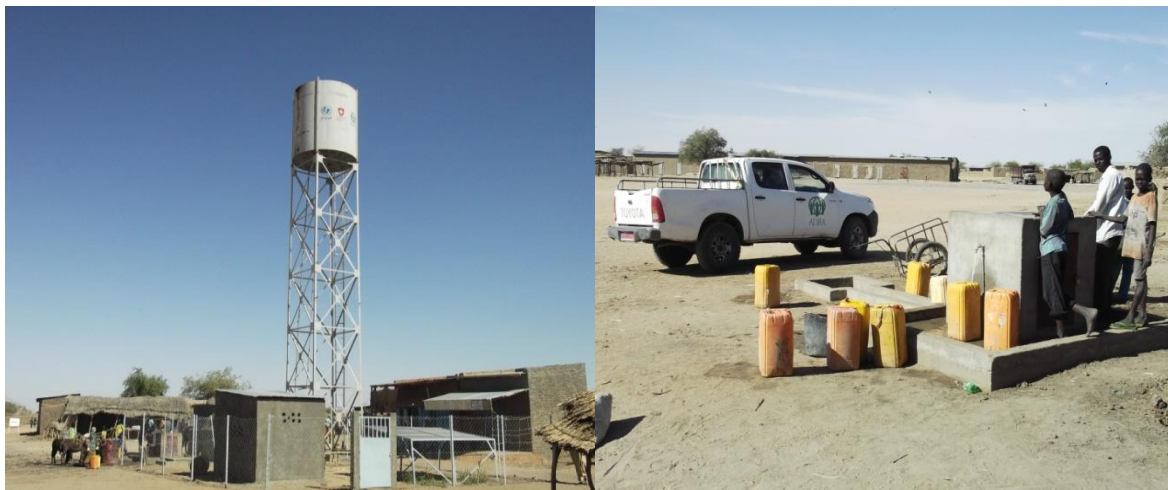
Figure 7 : Mini-AEP réalisée d'Ambassatnan Figure 8 : L'une des 6 bornes fontaines de la mini-AEP réalisée d'Ambassatnan
