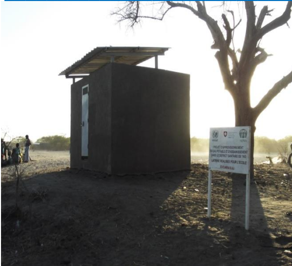
Figure 23 : Latrine de l'école Centre de N'Djaména-Bilala
